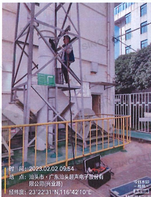
工艺废气排放口 (FQ-10831)
